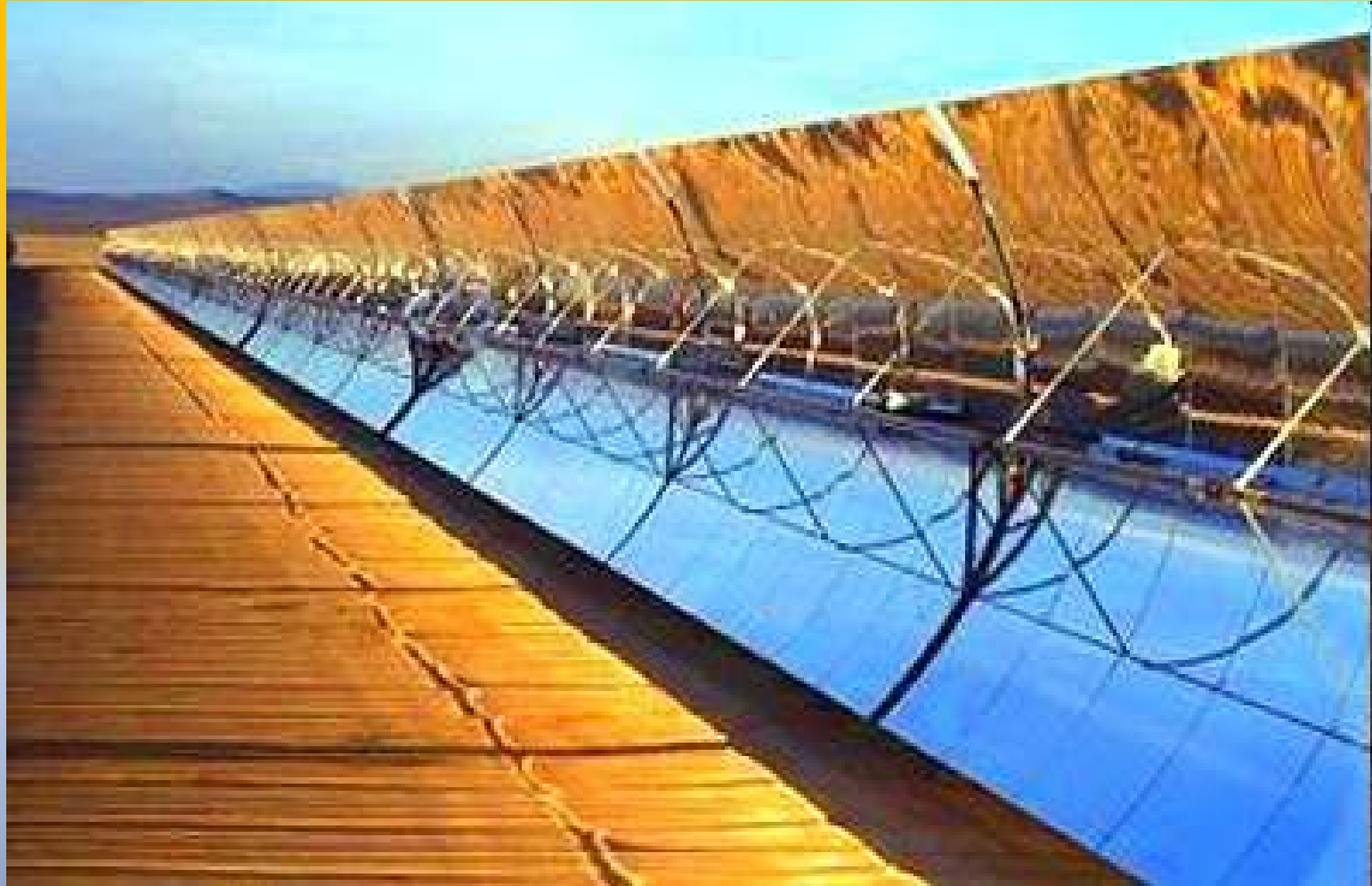
Солнечная теплоэлектростанция с параболоцилиндрическим концентратором Nevada Solar One
