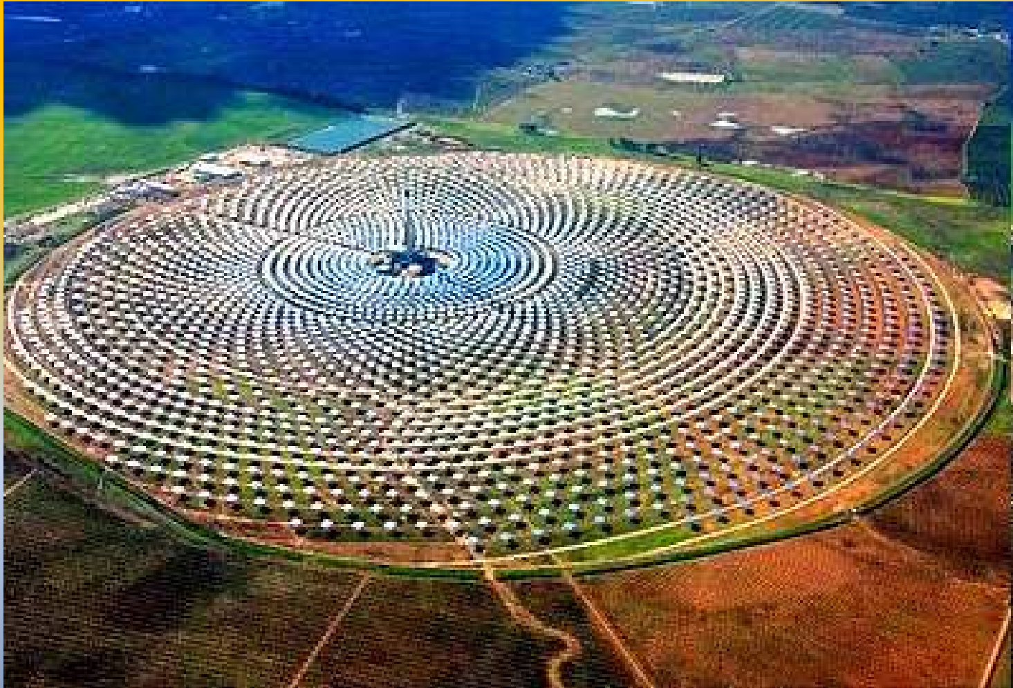
Солнечная теплостанция с гелиостатным полем. CSP-станция Gemasolar, Андалусия, Испания, 20МВт
